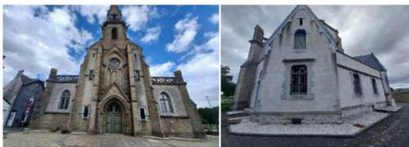
Figure 14 - Photographies des façades de l'église Sainte-Radegonde.
