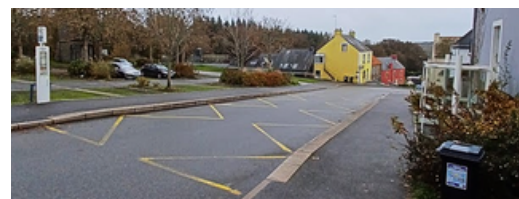
Figure 92 : Photographie des marquages d'un arrêt de bus à Penquesten (Amélie LE PORS)
