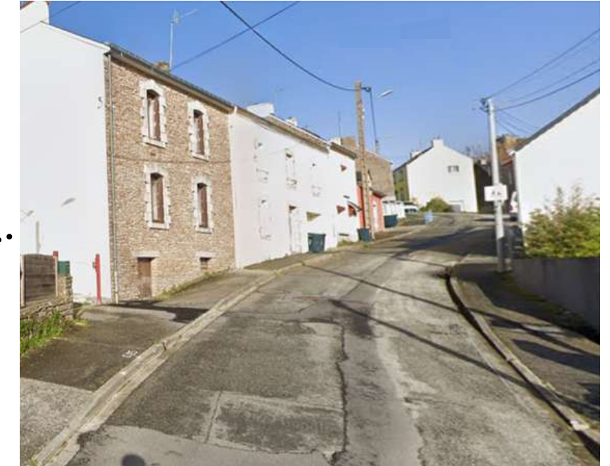
Photographie de l'état actuel - rue des Anciens Combattants.
