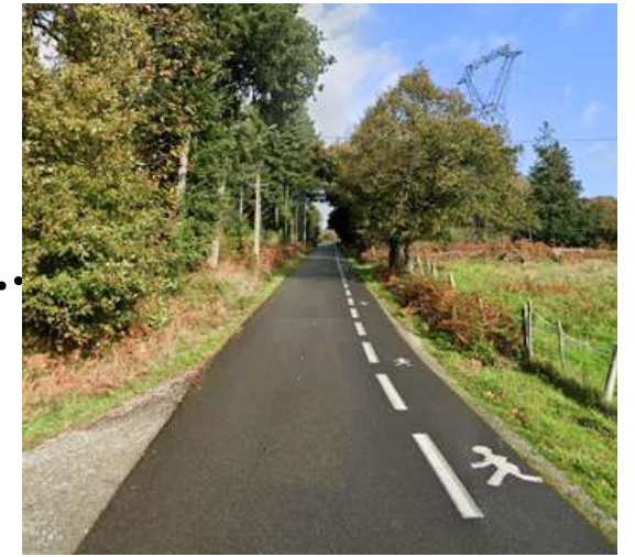
Photographie de la chaussée - rue de Ty-Henri (sur 500m jusqu'à Kermadec).
